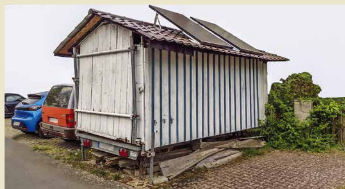
Kein Kfz? Nutzen Sie ihren Stellplatz durch einen mobilen Bauwagen! Die Stellplatzsatzung erzwingt solche Lösungen.
