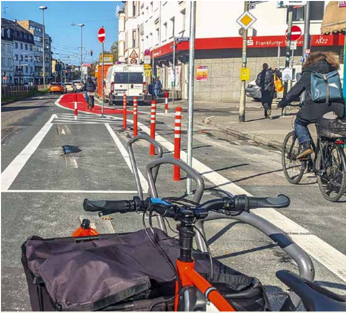
Die Fahrbahnbreite schwankt im Verlauf teilweise sehr, sodass an der Kreuzung zur Spenerstraße Fahrradbügel und zwei Parkplätze links vom Radweg eingerichtet werden konnten. Ungewöhnlich, aber effektiv!
