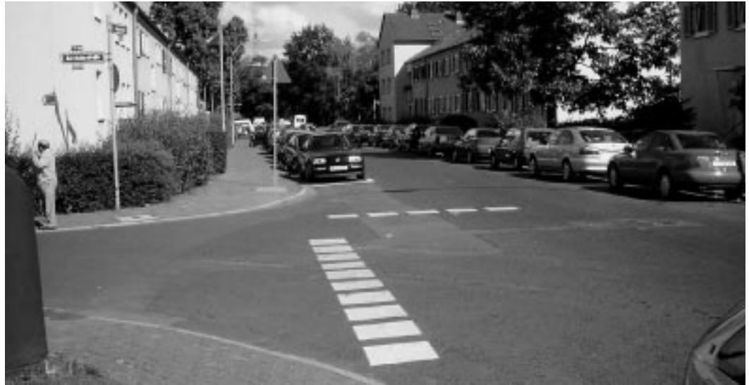
Abb. 1 Einmündung der Auerhahnstraße in die Jägerallee in Ffm-Griesheim: Markierungen verdeutlichen die Vorfahrtsregelung, rücksichtsvolleres Fahren ist die Folge.
