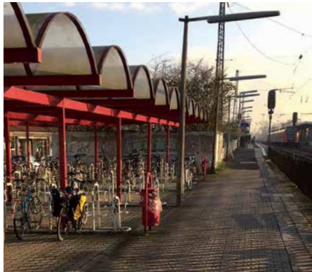
Die bestehende Fahrrad-Abstellanlage am Karbener Bahnhof – sicher, überdacht, direkt am Bahngleis
