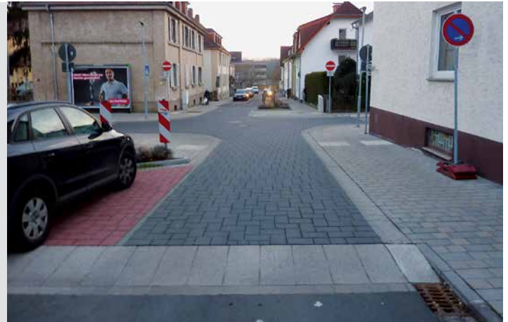
Einbauten zur Verkehrsberuhigung im Fahrtweg der geradeaus fahrenden Radler
